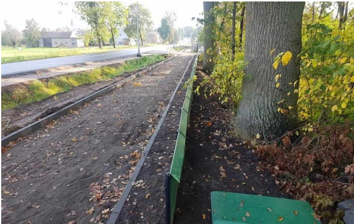
Rys. 27. Ogrodzenie ochronno-naprowadzające dla zwierząt na granicy pasa drogowego (źródło: https://siatmar.pl/html/categories/products/plotki-dla-plazow-hdpe )
