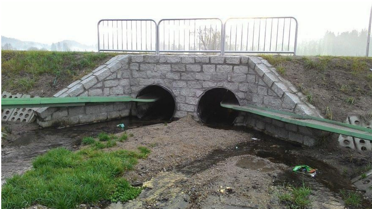
Rys. 25. Przejście dla zwierząt w formie półek w małych przepustach kołowych (źródło: http://www.pusz.com.pl/laminaty/polka.html )
