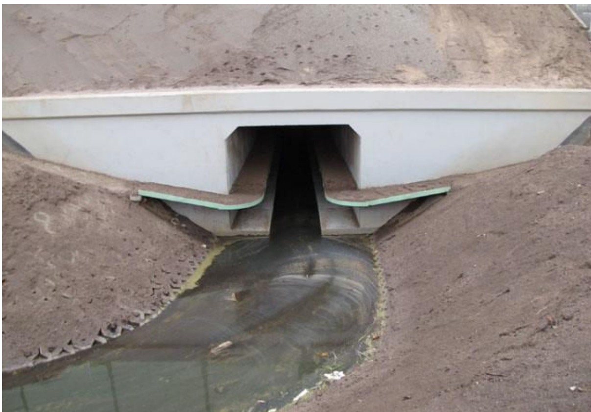
Rys. 26. Przejście dla zwierząt w formie półek w małych przepustach ramowych (źródło: http://www.pusz.com.pl/laminaty/polka.html )
