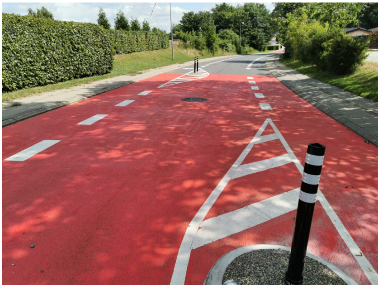
Rys. 19. Prawidłowe ukształtowanie esowania toru jazdy za pomocą szykan bocznych, Dania (Źródło: https://supercykelstier.dk/koncept/design-og-anlaeg/sti-og-trace-paa-supercykelstier )
